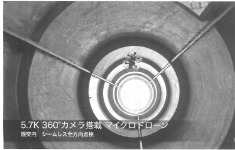
写真10 煙突内部への適用状況(下からの撮影)
