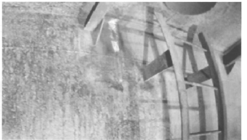
写真11 屋外貯蔵タンク内部(屋根近傍)
